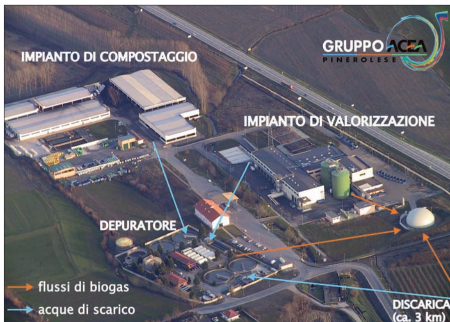
Fig. 1 – Il polo Ecologico Integrato – veduta aerea
